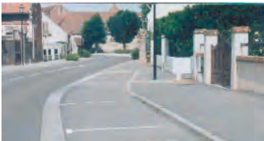
Stationnement matérialisé sur route principale ; les matériaux auraient pu être plus "ruraux" et la largeur du trottoir aurait permis de garder une bande plantée.
