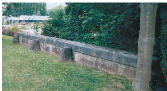
1. Pont sur l'Arré à St-Just
